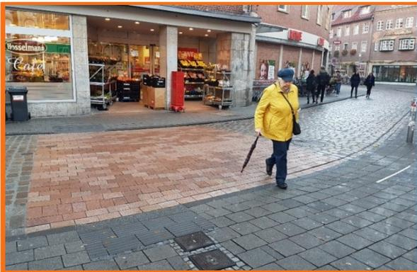
**Beispiel 3:** Abgeschliffenes und eng verfugtes Kopfsteinpflaster ist gut beroll- und begehbar. Der farbliche Kontrast unterscheidet den Übergang deutlich von den groben Pflastersteinen.
