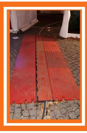
Beispiel 1: Mit einer Kabelbrücke lassen sich Zu- und Ableitungen abdecken.
