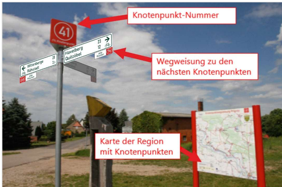
Abbildung 32: Elemente der Knotenpunktwegweisung (Darstellung: Büro Radschlag GbR)
